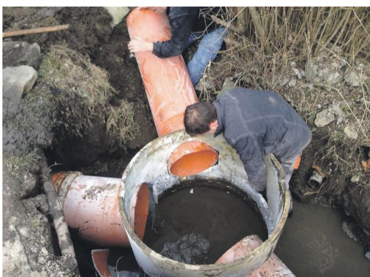
studničná skruž s betónovými zákrytovými doskami. Následne bola šachta obspaná štrkopieskovým materiálom.
