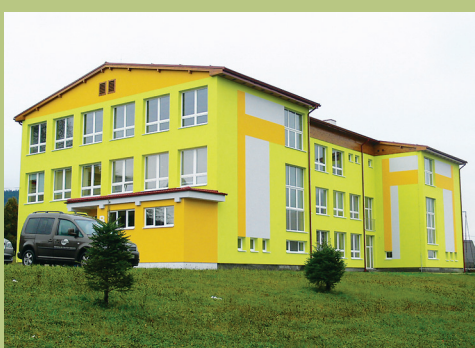
Nová budova základnej školy
