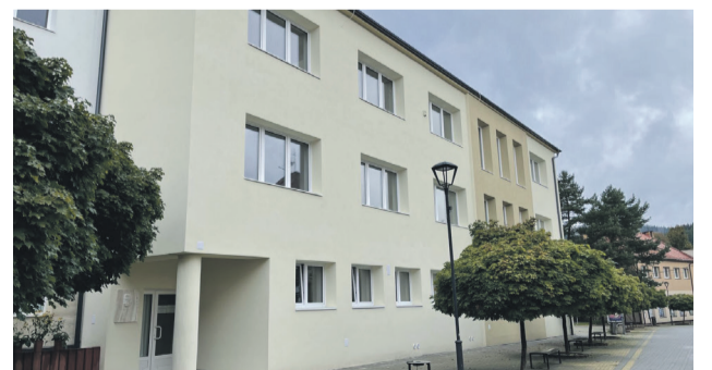
Zrekonštruoval a zateplil sa kultúrny dom.
