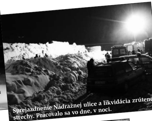
3. januára sa pod ťarchou mokrého snehu zrútila strecha autobusového nástupišťa. Našťastie, nehoda sa zaobišla bez vážnejších zranení.
