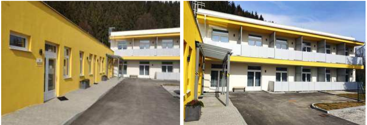
Zariadenie sociálnych služieb
