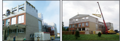
Výstavba nového podlažia
